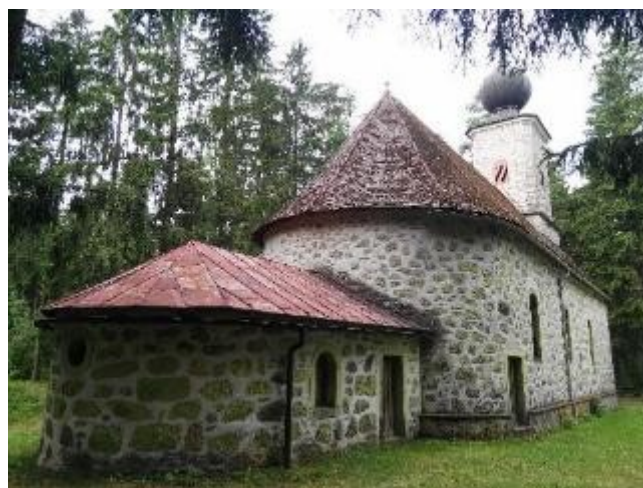
Kapellenanbau | Přístavba kaple Maria Rast, Bild Wolfgang Strasser
