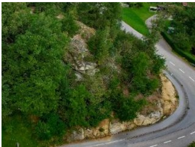
Steinfelden, Hanrieder Straße, Sarleinsbach, Bild Gemeinde
